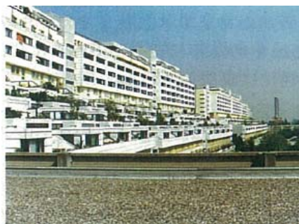
▲道路上空の住宅側面
