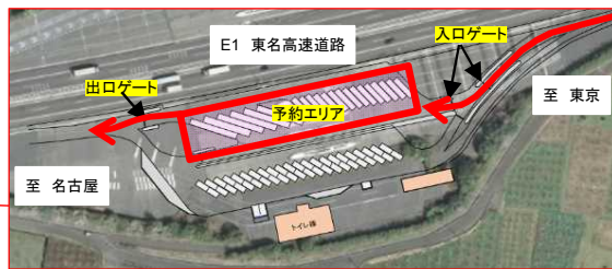
＜旧豊橋本線料金所跡地＞
