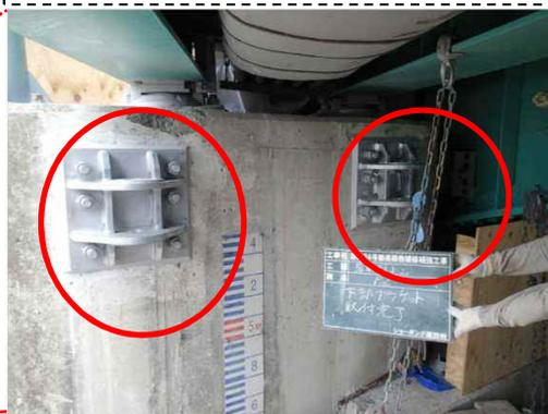
支承補強構造(橋軸直角方向)
