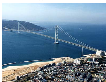
明石海峡大橋 （国道28号（神戸淡路鳴門自動車道））
