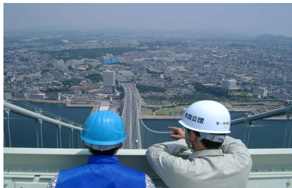
塔頂で橋の説明を受ける参加者
