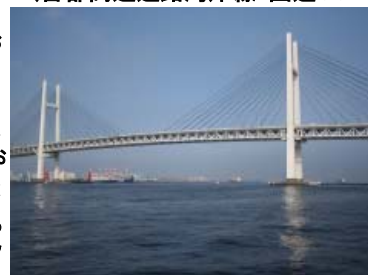
横浜ベイブリッジ （首都高速道路湾岸線：国道357号）
