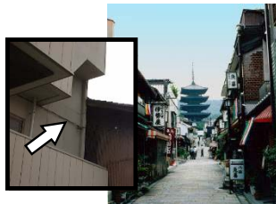
写真2 軒下配線 (京都市八坂通り)
