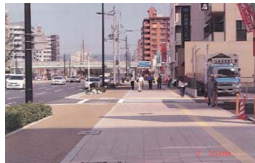
国道9号五条大宮拡幅工事 (出典: 京都国道事務所HP)
