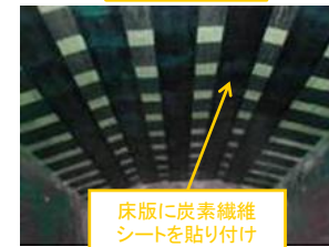
KK線の構造の補強イメージ
