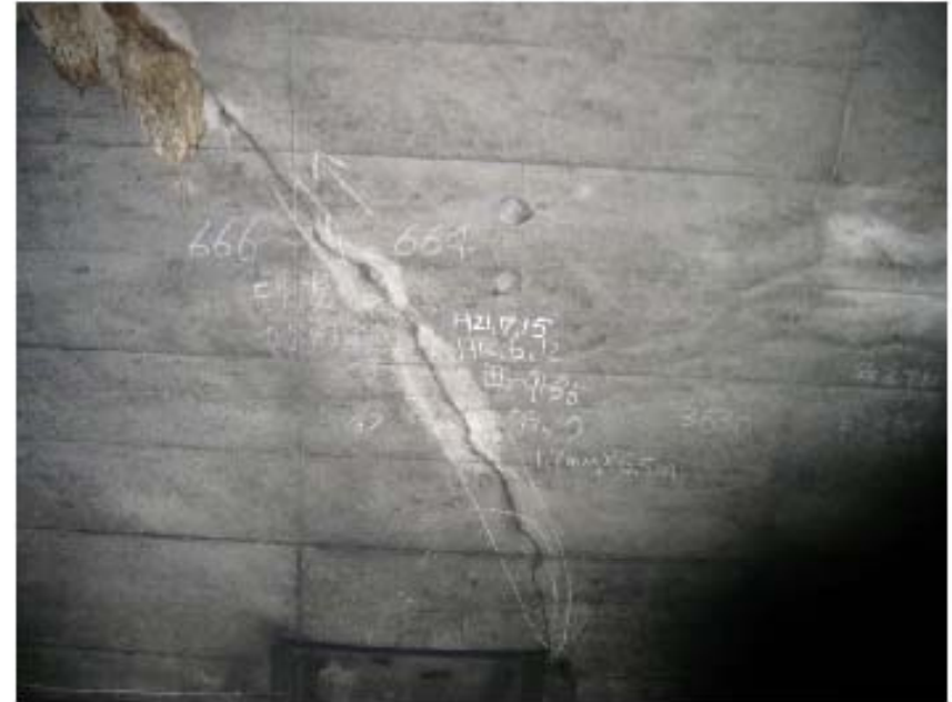
Bブロック(追越側) 西9+65 KP85.025 覆工コンクリート 本体クラック 1.7×6000 ・クラックの進行は見られない。
