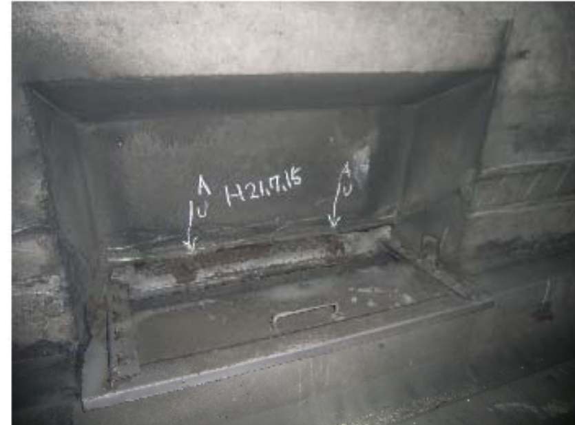
Bブロック(追越側) 西 10+95 KP85.155 送風口 アンカーボルト破損
