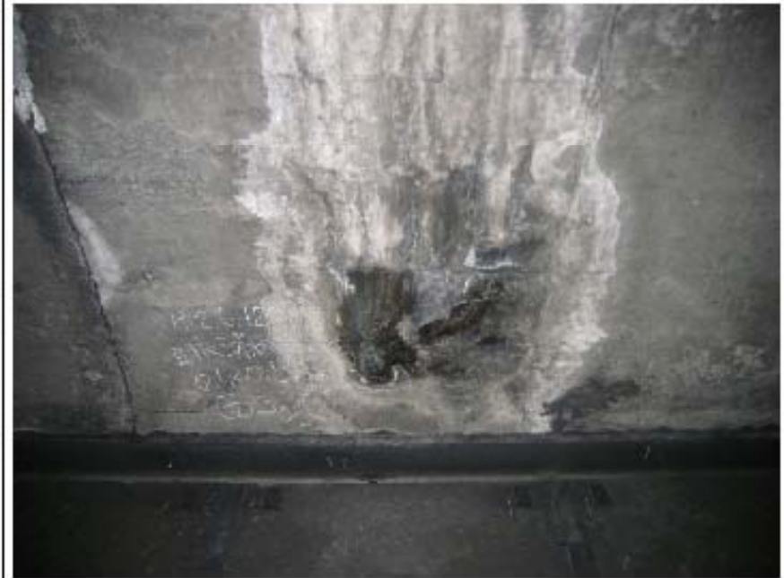
Bブロック(追越側) 西 3+75 KP84.435 覆工コンクリート 本体 豆板 大きな進行は見られない。
