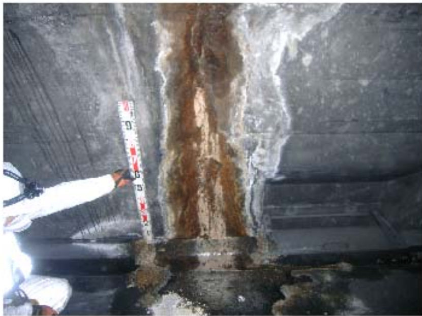
Bブロック(追越側) 西 1+83 KP84.243 下部の湧水状況
