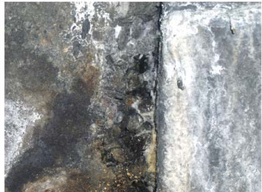
Bブロック(追越側) 西 1+83 KP84.243 目地部の豆板
