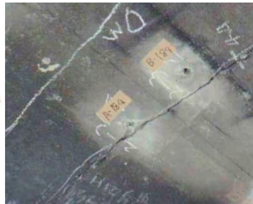
落下の衝撃によるものか、その前からのひび割れかは不明
