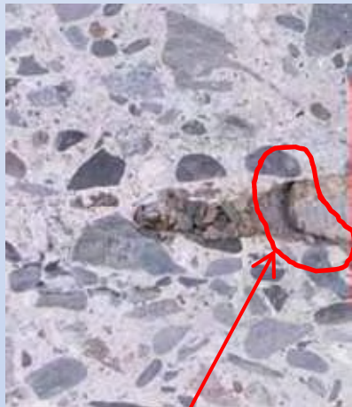
ボルト先端部には 隙間がみられる。
