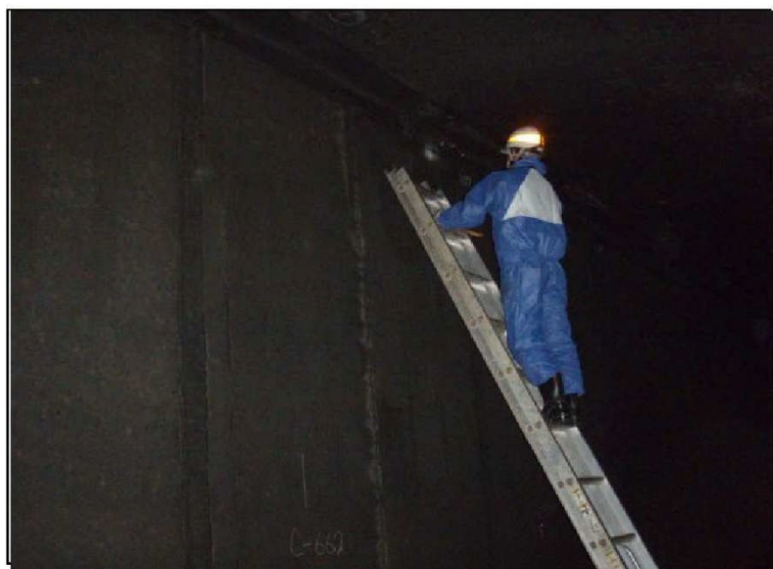
① 隔壁上部点検
