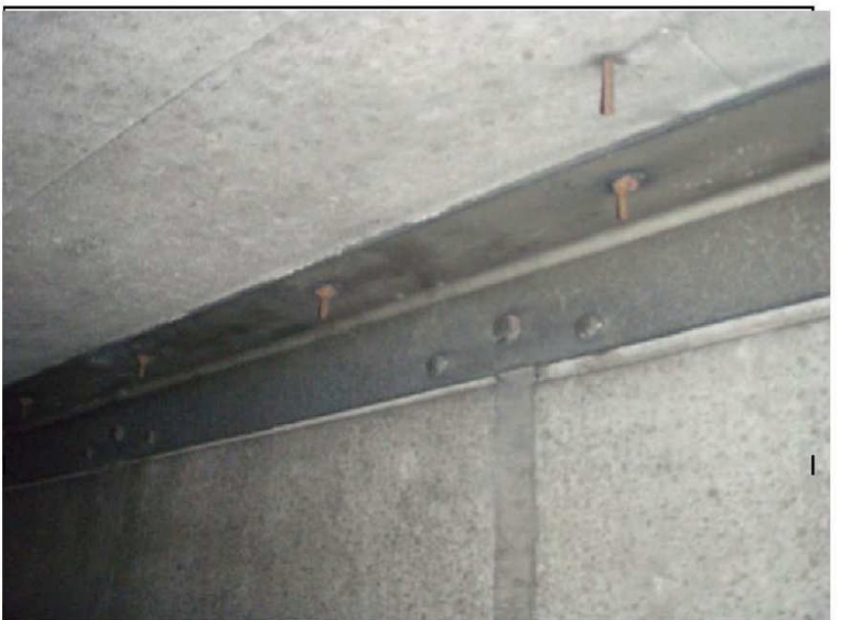
② 隔壁上部アンカー(追越側)
