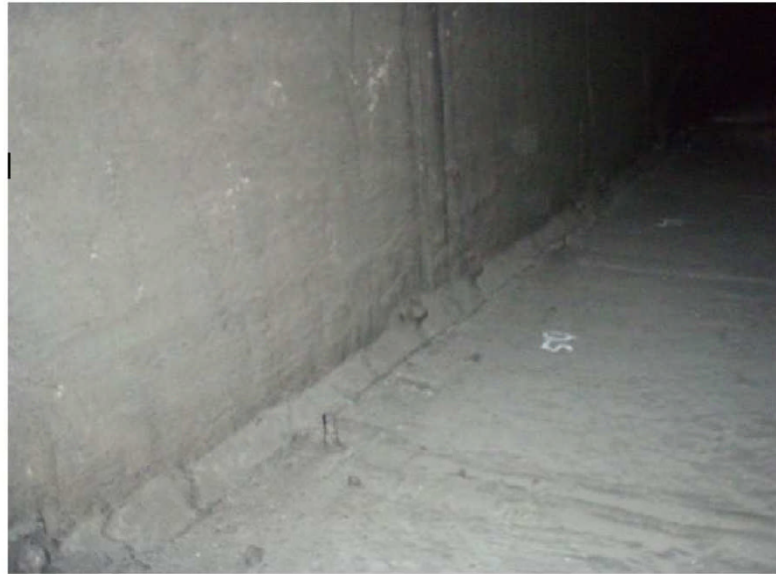
① 隔壁下部(走行側)
