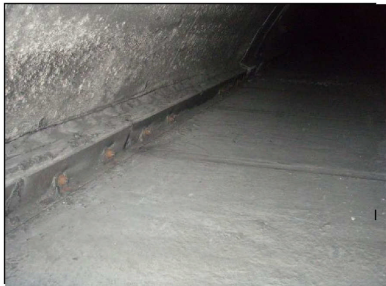
③ 天井板覆工取付け部
