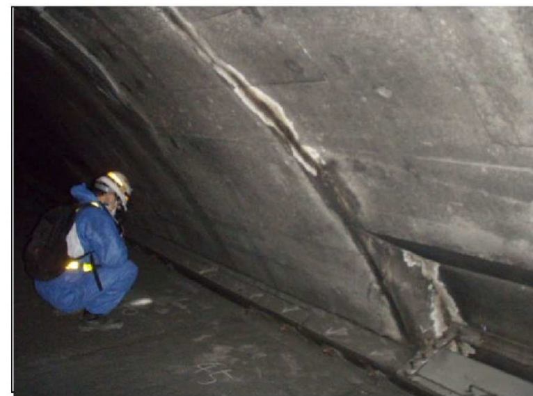
② 天井板覆工取付け部点検
