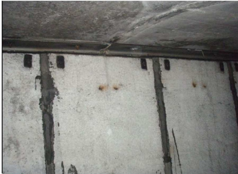
① 隔壁上部アンカー(走行側)
