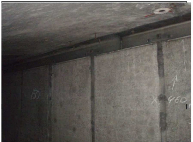
② 隔壁上部アンカー(追越側)
