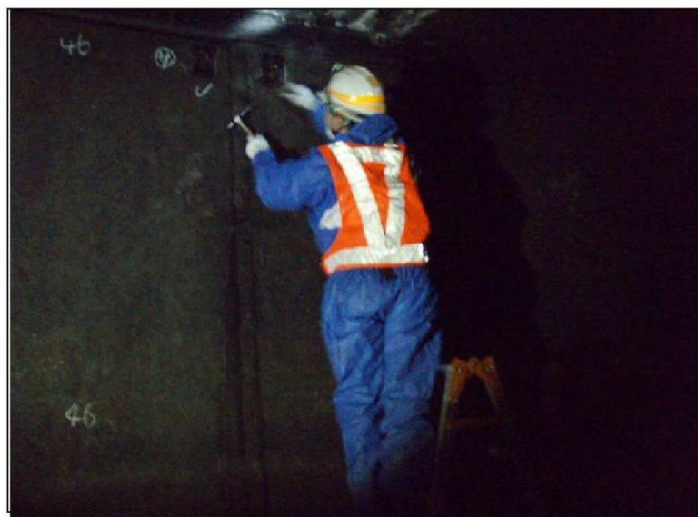
① 隔壁上部点検
