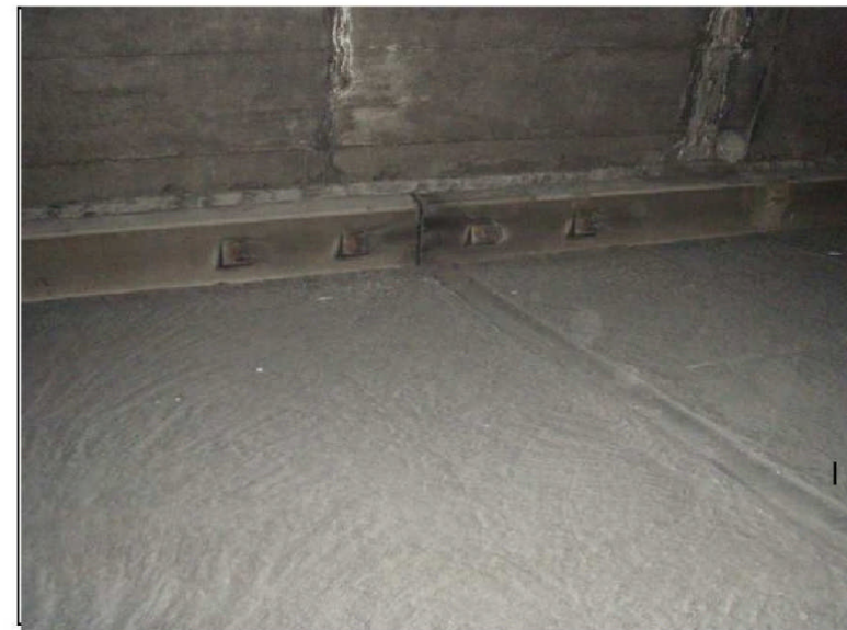
③ 天井板覆工取付け部
