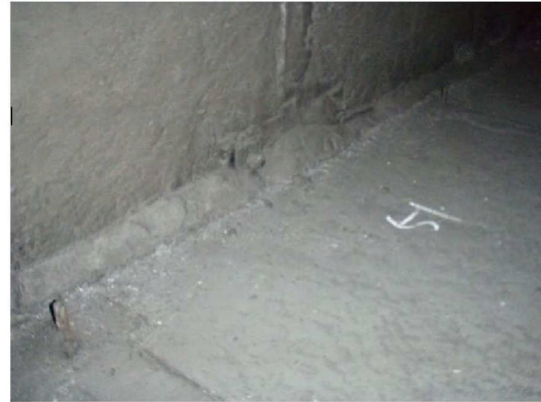
① 隔壁下部(走行側)
