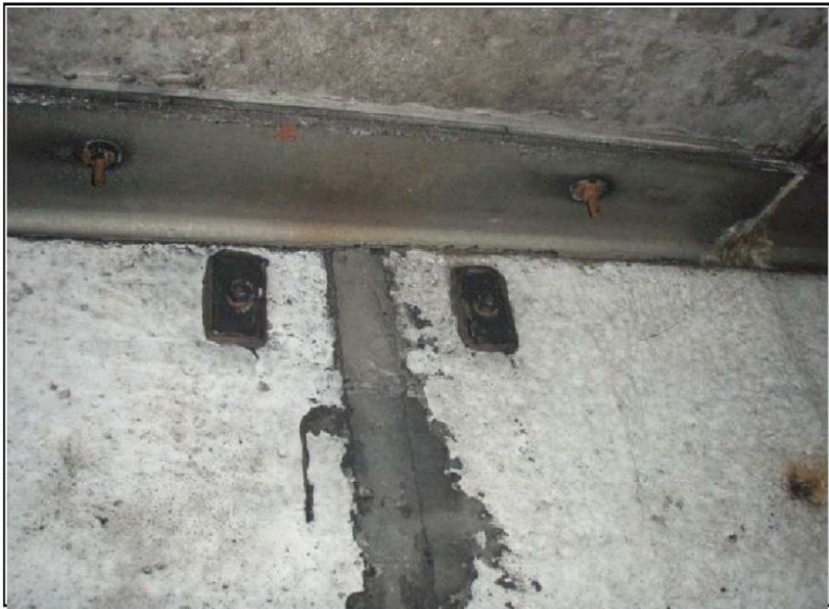
① 隔壁上部アンカー(走行側)
