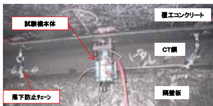
引抜試験の実施
