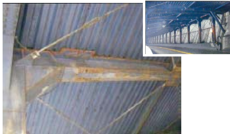
スノーシェッドの腐食状況
