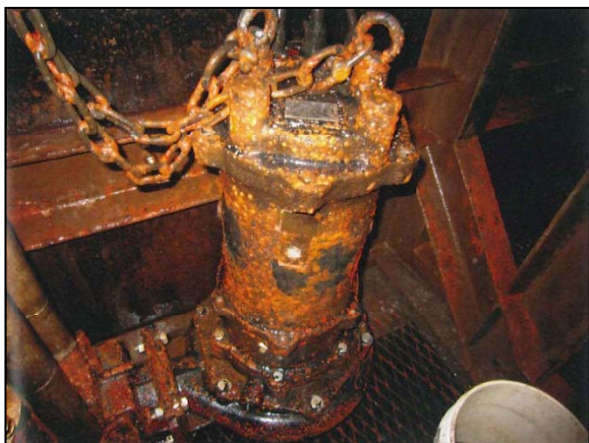
消雪パイプの河川からの取水ポンプの老朽化
