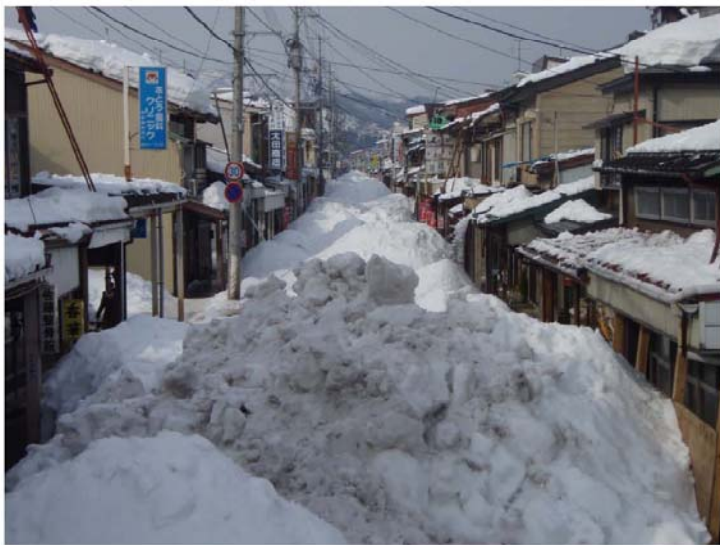
新潟県上越市 上越市一斉雪下ろし 屋根雪で埋もれた道路 (H23.2.6撮影)
