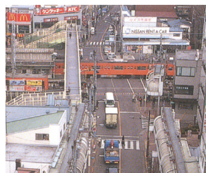
対策前の状況
