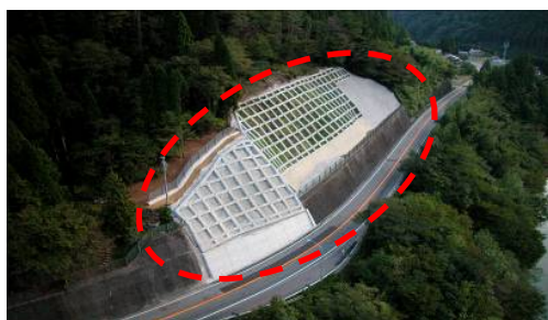
【防護コンクリートによる斜面崩落防止】
