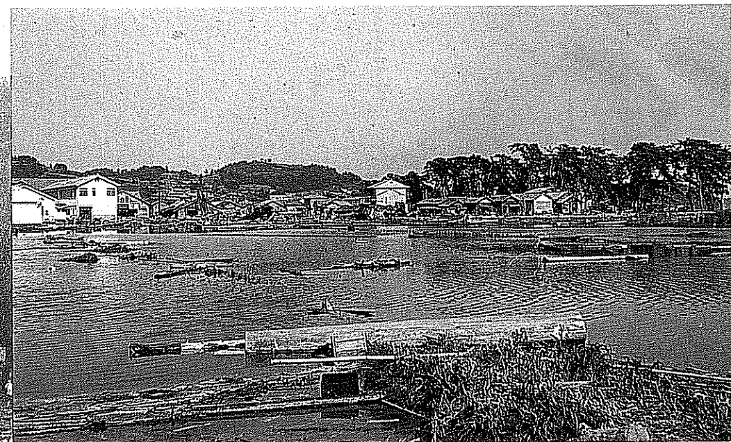
左手に志津川組合病院が見える。 右手は松原。現在はここを国道45 号線が通っている。
