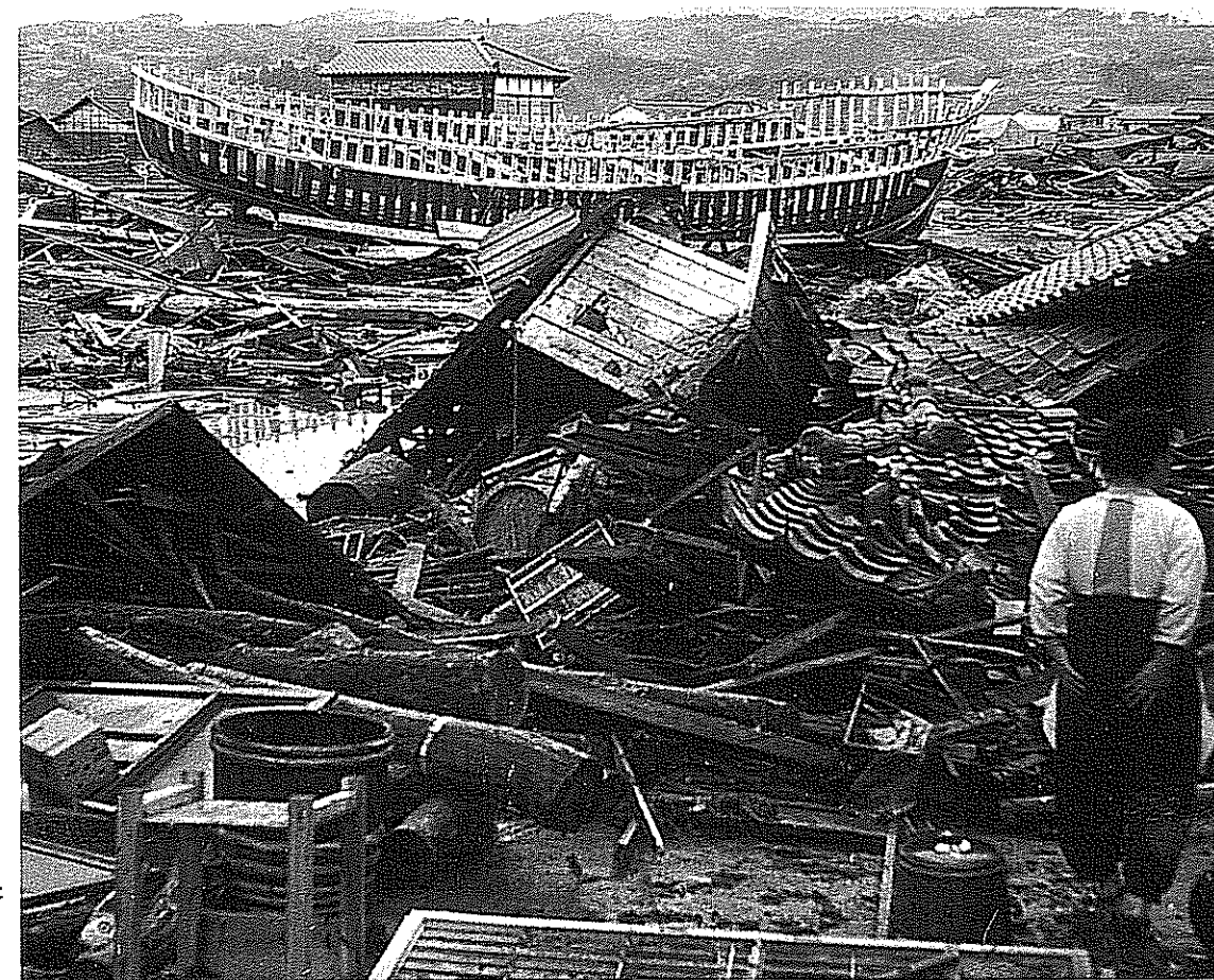
倒壊した家々と流れ出た建造中の船
