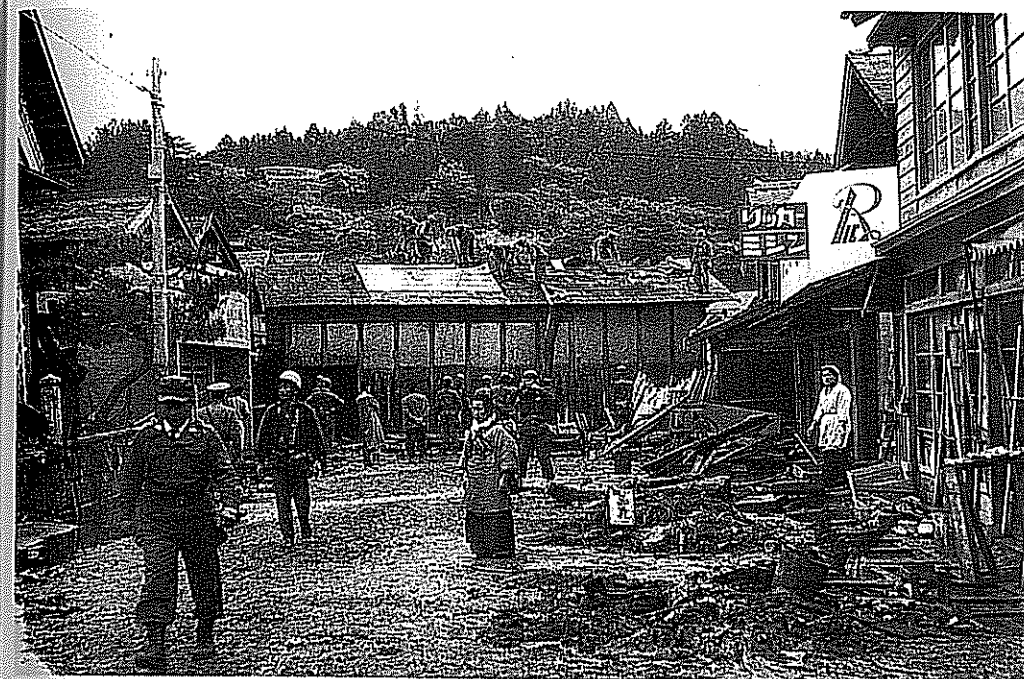
国道をふさいだ家屋の取り壊し作業 （十日町）
