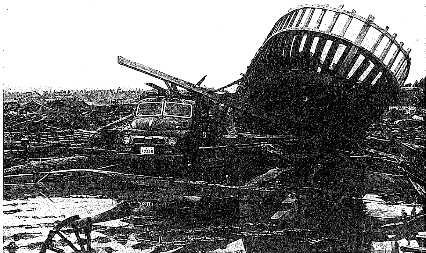
建造中の船と押しつぶされたトラック。 (大森地区)
