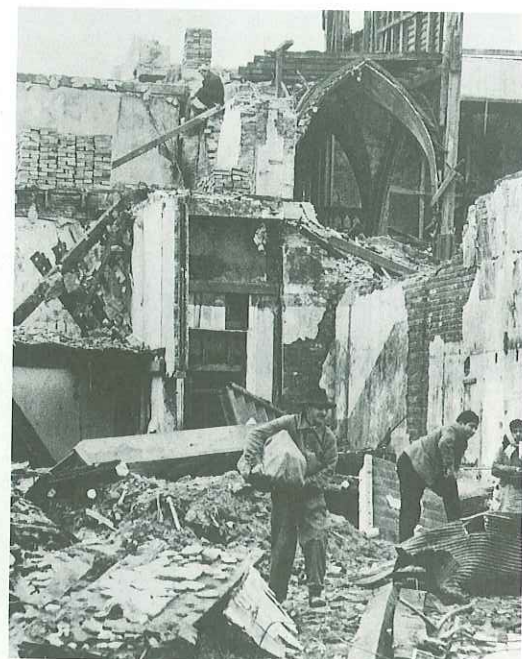
ドイツ風の、美しかった街は、見るかげもなく崩れ落ち地球縦断隊員の目に痛かった。（バルデビア市）
