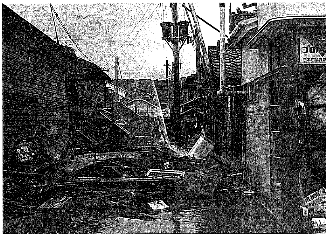
五日町永井屋薬局横の通 り 右手にはスタンドがあっ た。
