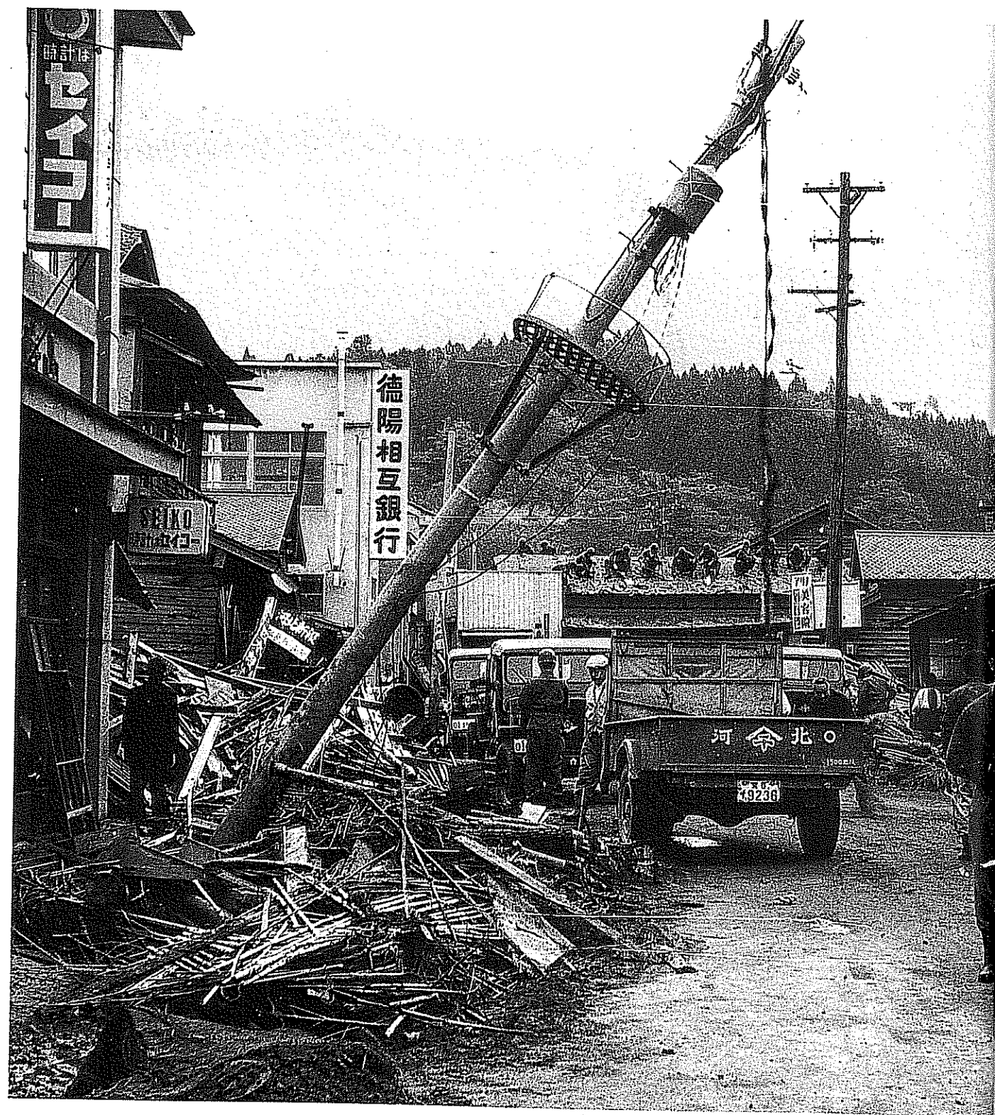
自衛隊による復旧作業（十日町、現在の商工会付近） 自衛隊や警察はその機動力を発揮して復旧作業に取り組んだ。 茫然自失の被災者達にとって、その姿はことさらたのしかった。
