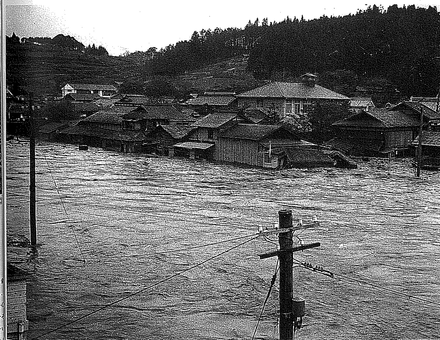
水没する五日町の家々、 中央の高い建物が志津川警察署
