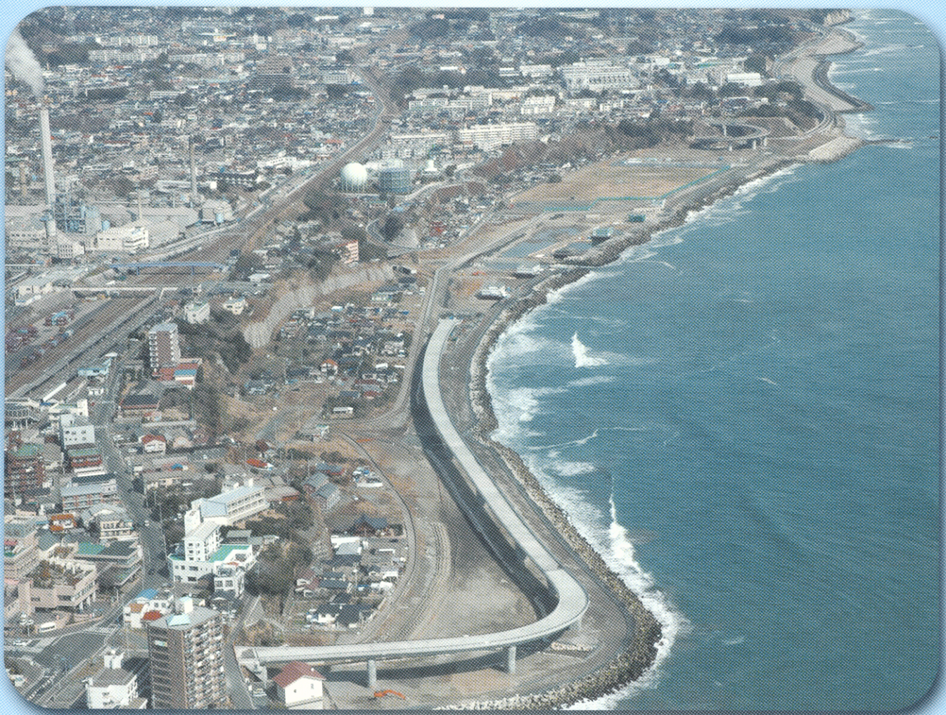
国道6号バイパス旭町アクセス付近
