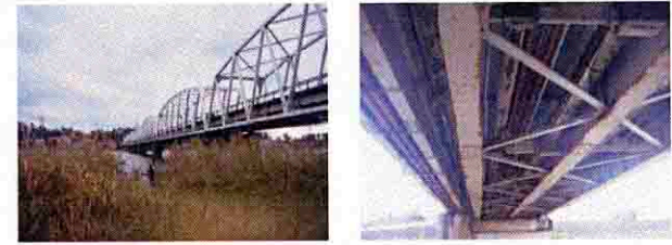
国道305号 新保橋（坂井市三国町新保）S41架設
