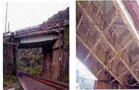
国道8号 鳩原跨線橋（敦賀市鳩原）S27架設
