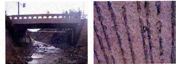
三国東尋坊芦原線 浜地橋（坂井市三国町浜地）S30架設
