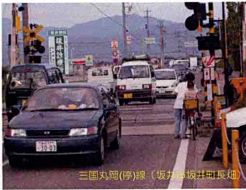
踏切に歩道がないため車道にはみ出して通行
