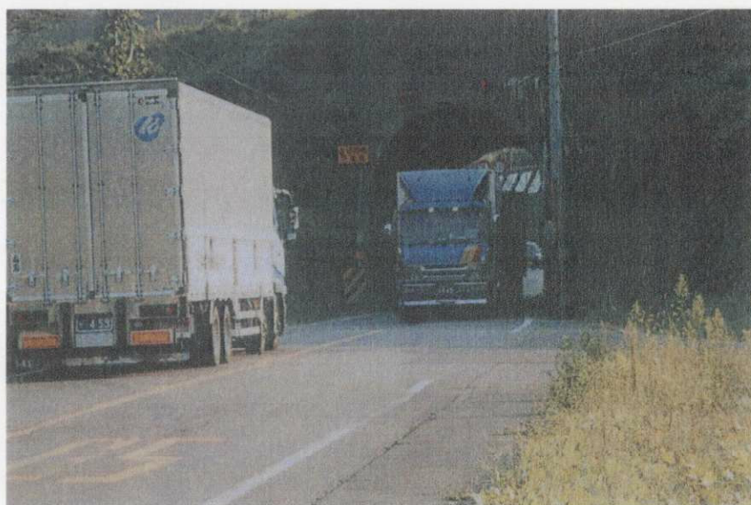
一般国道161号 疋田トンネル
