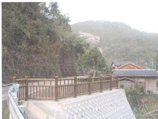
木製転落防止柵（馬路村 北路甫木）
