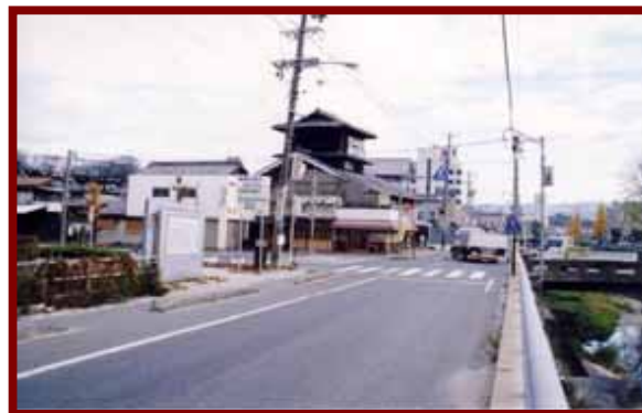
工事前 狭隘な歩道と単路の車道
