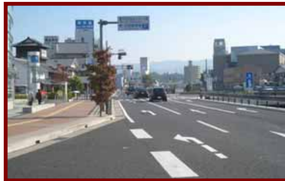
工事後 電線類地中化により ゆったりとした歩道や開 放感ある道路空間
