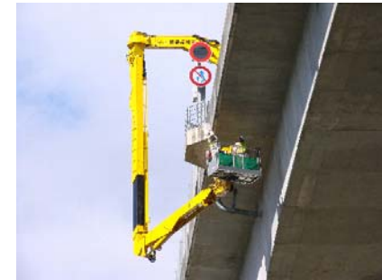
橋梁点検車による定期点検
