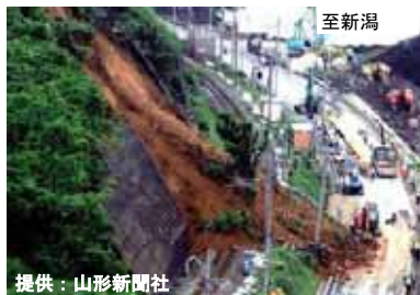
図3 法面崩壊(鶴岡市小岩川地区)
