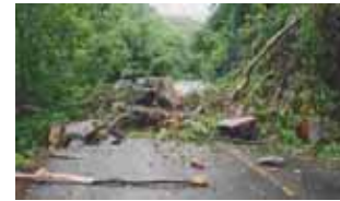
H18.6土砂災害時の状況
