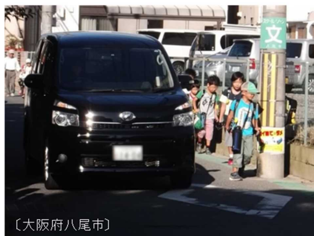
図 10 電柱による交通安全阻害
