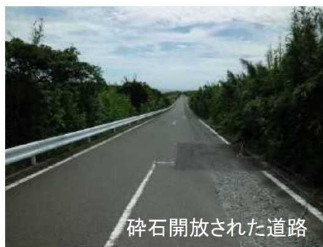
写真 8 碎石開放（仮復旧の未実施）
