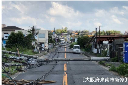
図 9 平成 30 年台風 21 号による電柱の倒壊による停電被害状況
