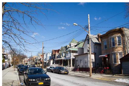
ブルックリンの住宅街における架空線
