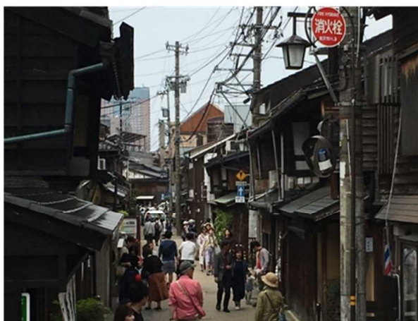
【石川県金沢市】 風情ある伝統的建造物群にそぐわない電柱・電線。
