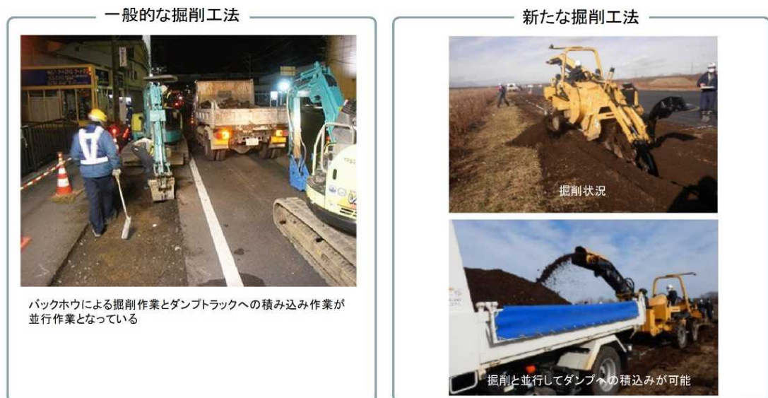
図 27 新たな掘削工法
