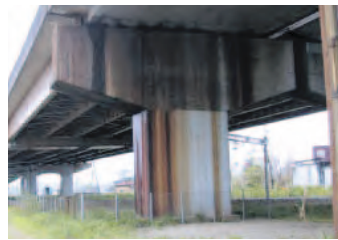
【耐震補強の実施により新潟県中越地震では甚大な被災無し】
