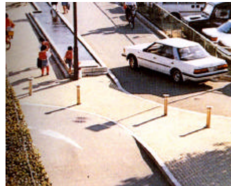
ボラードの設置等による通り抜けの抑制
