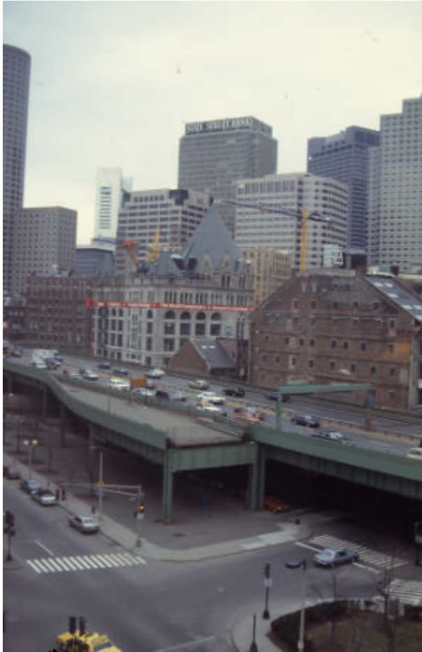
ボストン 高架の高速道路 現在撤去して地下化。 地上は遊歩道に。
