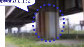
橋脚補強により橋脚の被災なし 鋼板巻き立て工法
