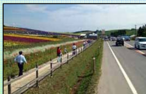
電柱の片寄せ
