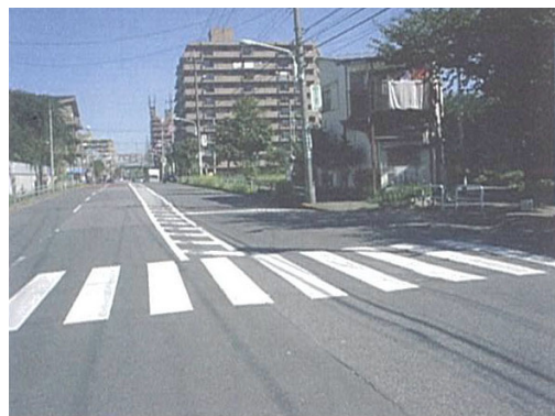
不動通り 前谷津川緑道交差点付近 (実験前)
