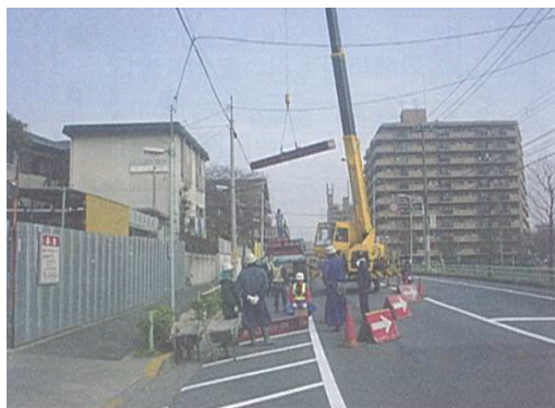
不動通り (工事中)
