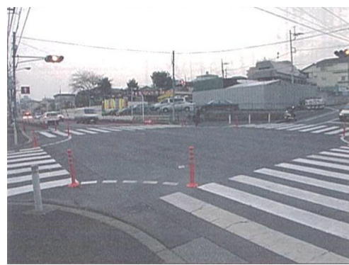
高島平寄り交差点 (工事中)
