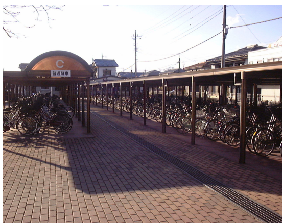
群馬八幡駅駐輪場
