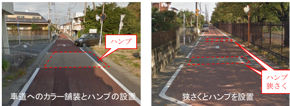
図 6-4 その他の道路における対策状況（高崎市の事例）
