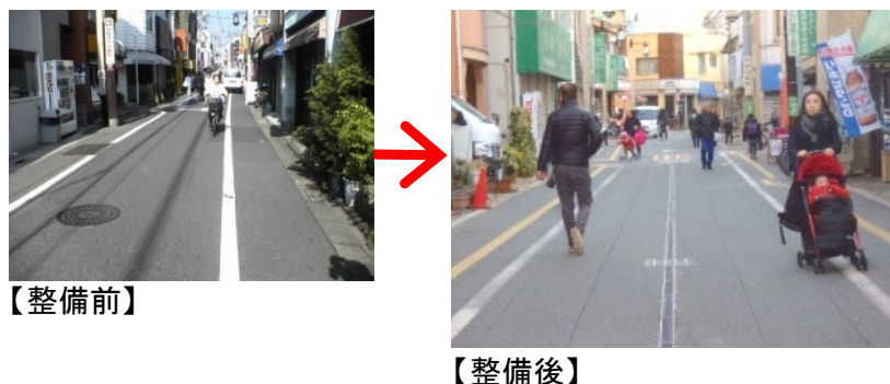
図 2-22 道路中央への排水施設整備による沿道施設との段差解消状況
