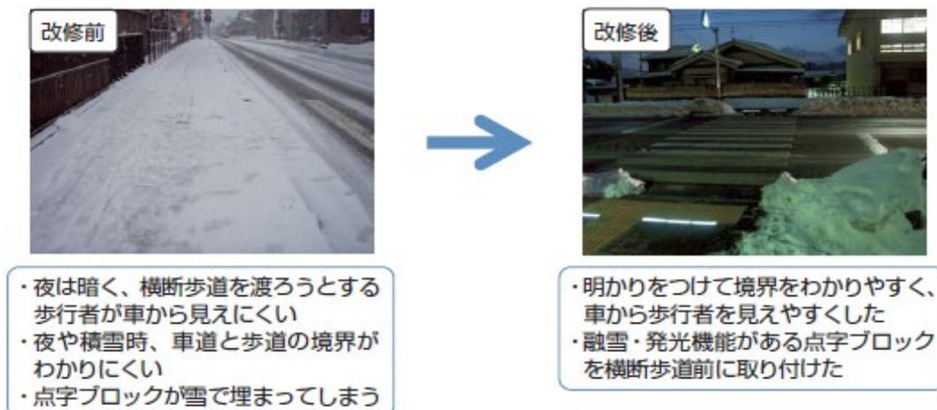
図 2-5 融雪・発光機能付き視覚障害者誘導用ブロックの設置（基準適用外）
