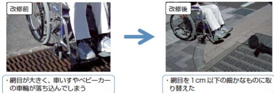
図 2-4 側溝蓋の網目の改修（基準適用外）
