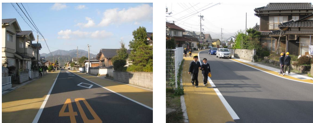
写真 6-2 整備後の状況（下関市の事例）
