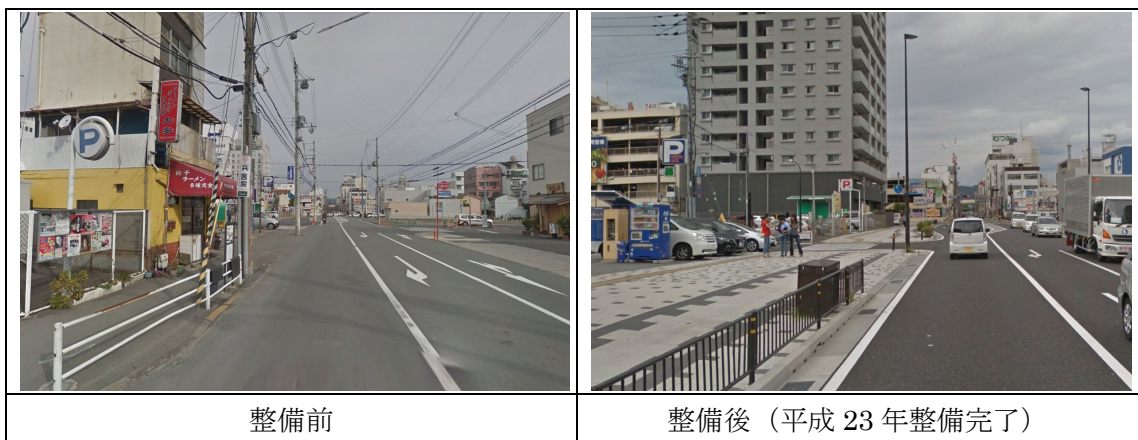
写真 2-11 無電柱化箇所（自歩道整備）の状況
