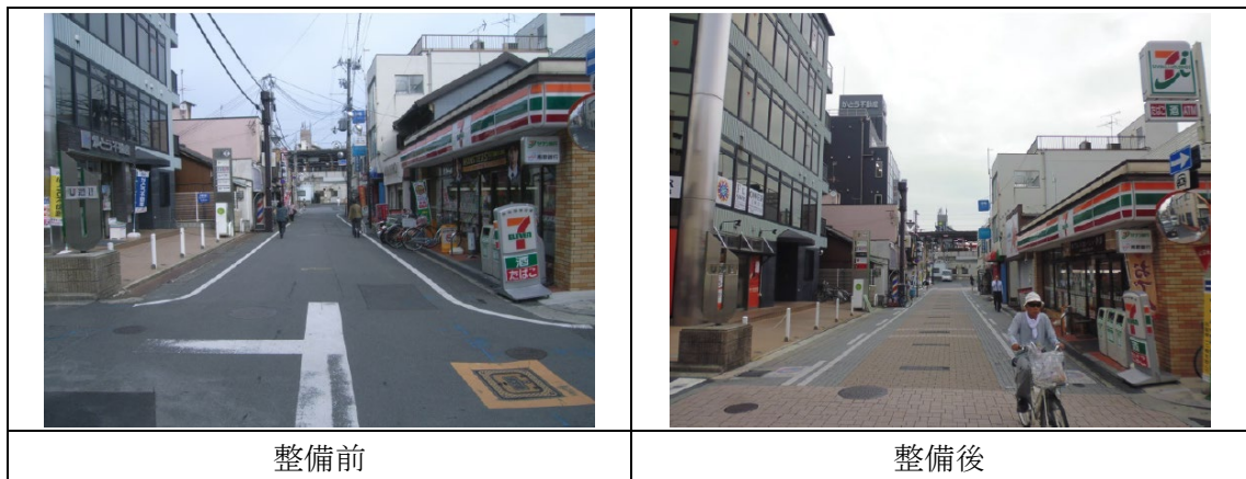
図 5-8 整備前後の状況
