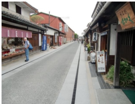
写真 2-7 道路端部への天然石使用状況
