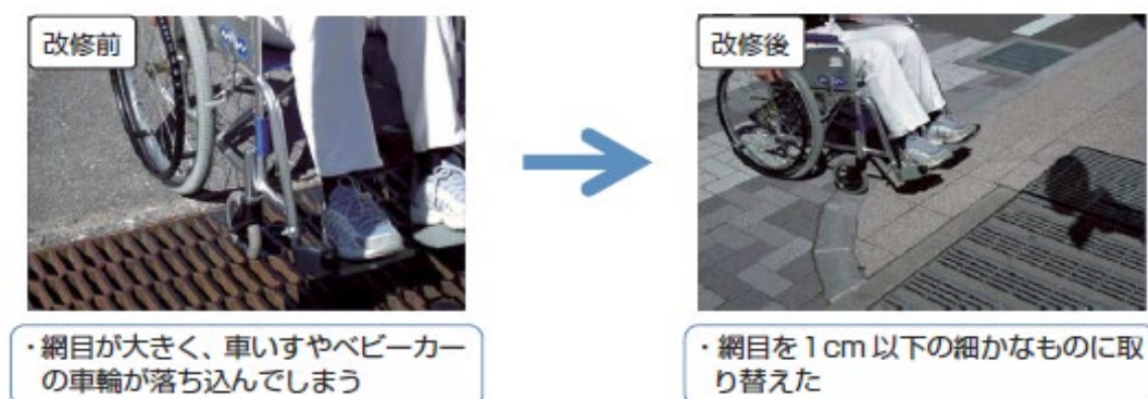
図 2-4 側溝蓋の網目の改修（基準適用外）
