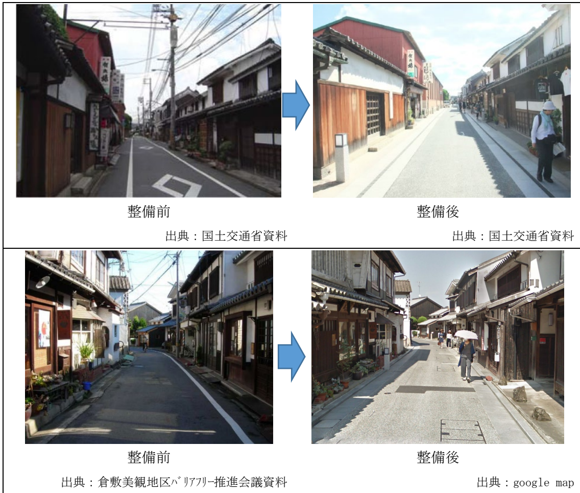
写真 2-6 無電柱化整備の状況
