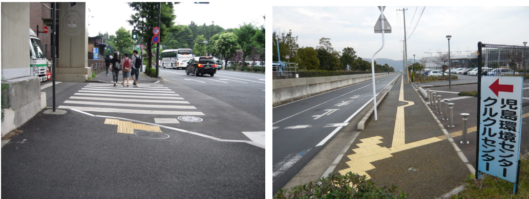
写真 5-2 通行可能範囲をカバーしていないものや直線上に設置されていない事例
