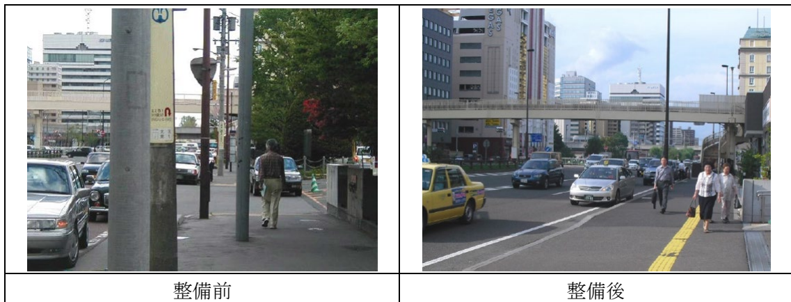
図 5-1 札幌市内の国道における無電柱化整備状況
