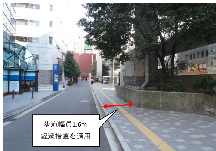
図 6-10 高速道路橋脚での歩道幅員が縮小状況（横浜市の事例）
