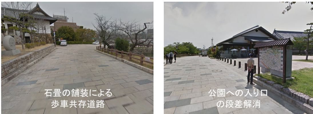
図 6-5 歩車共存道路の状況（岸和田市の事例）
