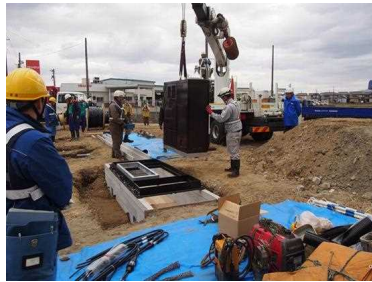
事前検証の全景(延長約10m)
