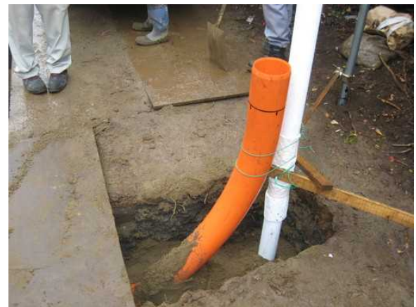
引込み管の立ち上げ状況
