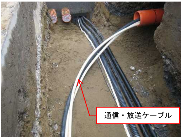
通信・放送ケーブルの引込状況
