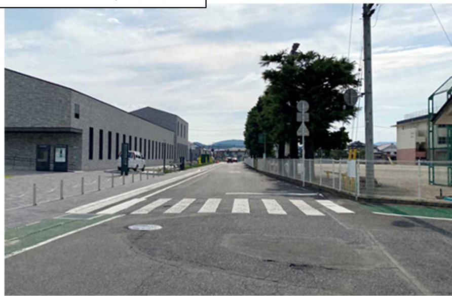
現地状況(設置前)
