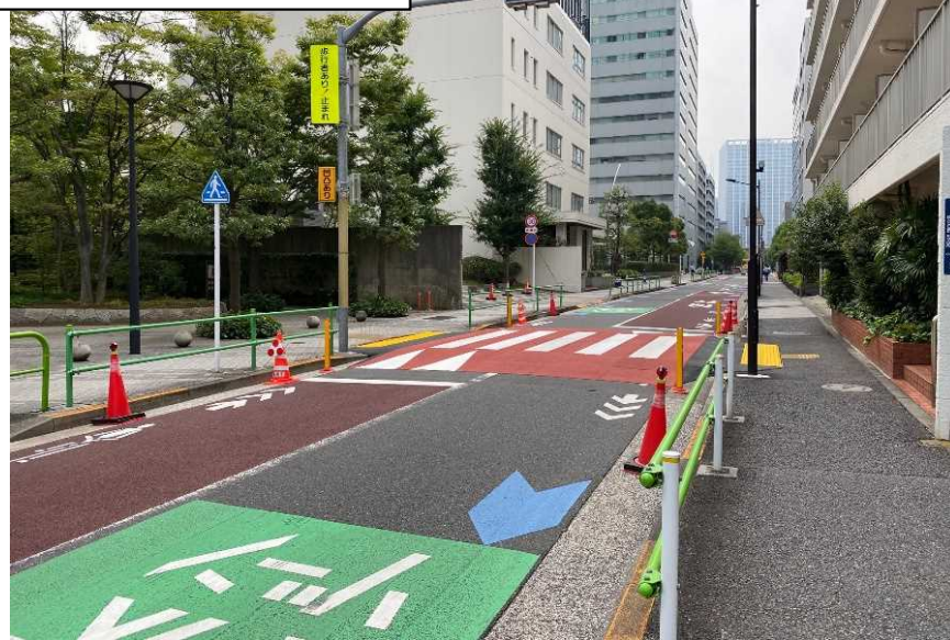
現地状況(設置後)
