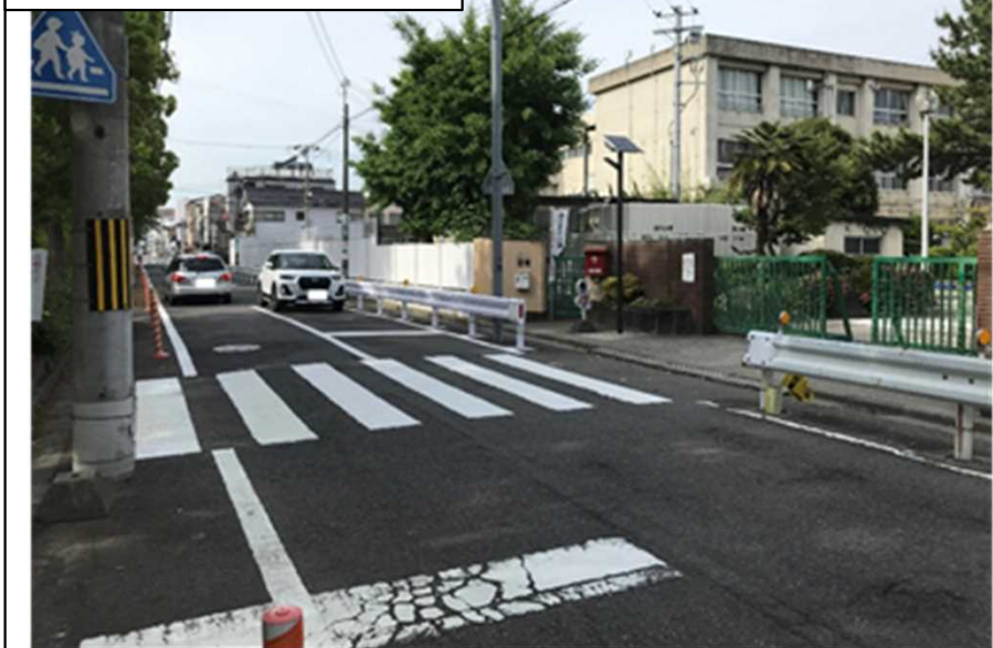
現地状況(設置前)
