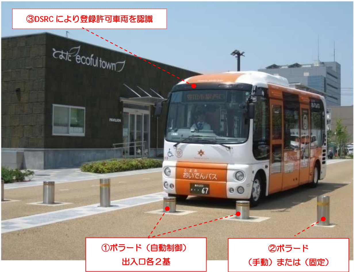
図 4-2 ライジングボラードのシステム構成
