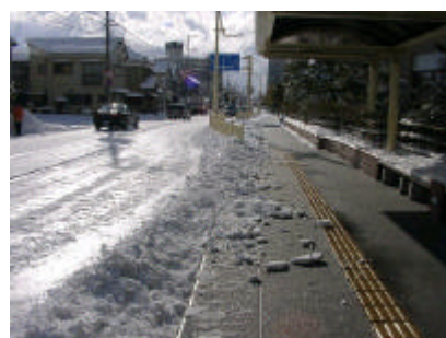
写真 11-2-2 横断歩道接続部・バス停部における堆雪の事例
