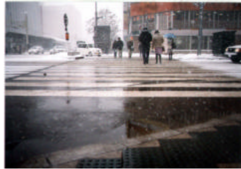
写真 11-1-4 横断歩道部へのロードヒーティング設置事例
