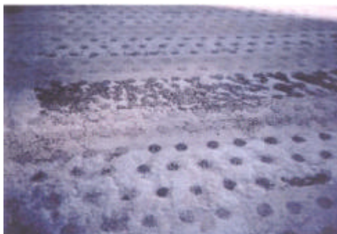
図 11-1-6 弾性物質被覆舗装（円形のゴムを埋め込む工法）の施工事例
