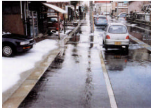
写真 11-1-2 消雪パイプ設置事例
