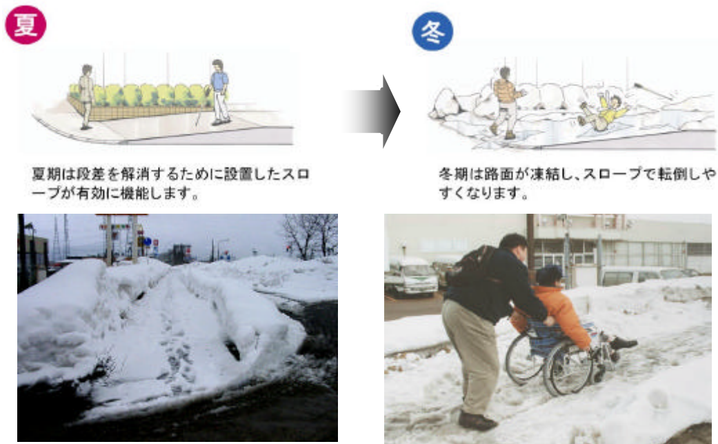
図 11-1-1 縦断こう配 5 % を超える箇所の冬期の状況
