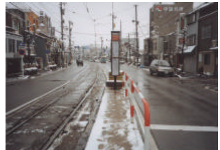
雪が積もり滑りやすくなった路面電車停留場の事例
