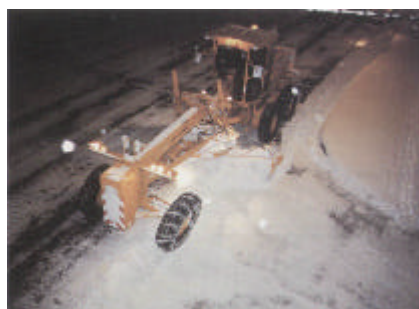
(シャッターブレードによる作業状況)
