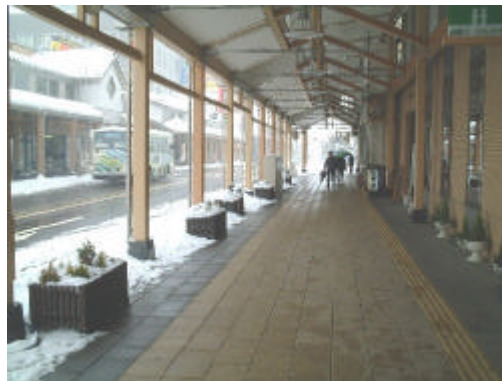
写真 11-1-3 アーケード設置事例
