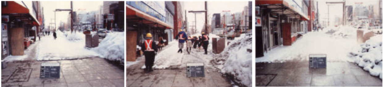
段差発生状況
