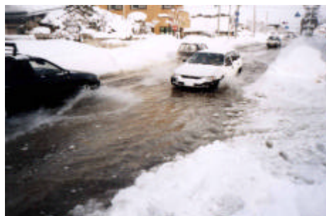
写真 11-1-11 流雪溝が詰まって道路が冠水した例
