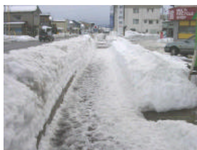
写真 11-2-4 除雪機械通過後の残雪の事例
