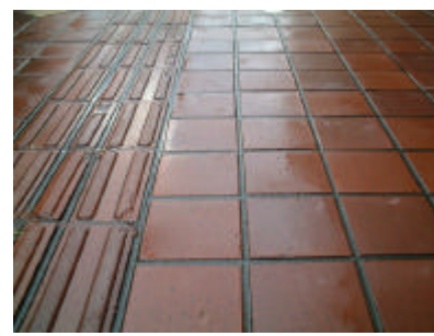
写真 2-1-2 冬期でも滑りにくいブロック路面材の例
