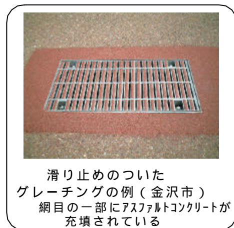
図 2-1-18 歩行動線上に排水柵を設置する場合のイメージ
