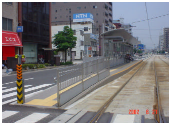
写真 5-4-1 傾斜路の例 ( 広島電鉄 十日市町停留場〔国道 54 号〕 )
