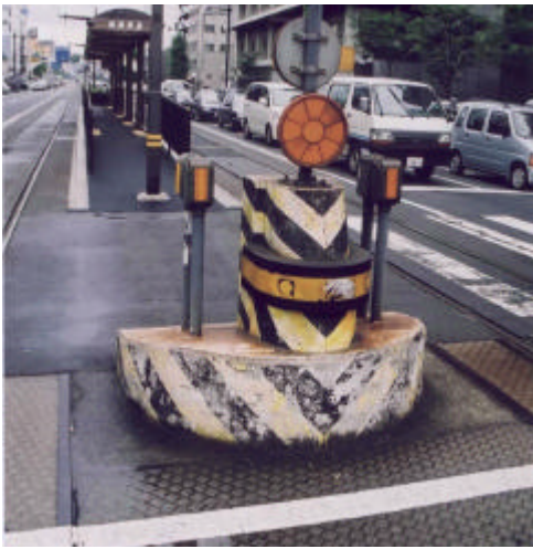
写真 5-3-4 衝突防止用施設の例 (岡山電軌 郵便局前停留場〔国道2号〕)
