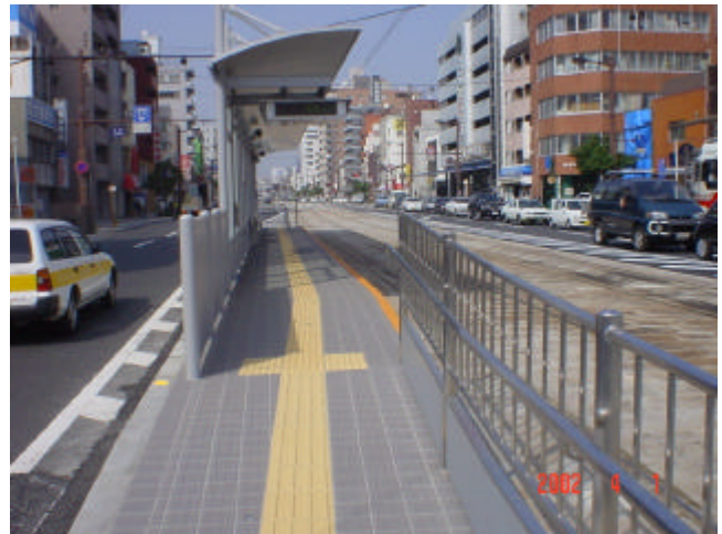
写真 5-3-5 柵の設置例 (広島電鉄 十日市町停留場〔国道54号〕)
