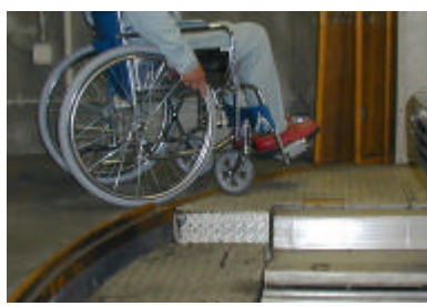
写真一 段差・隙間の解消 (歩行者出入口側)
