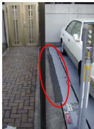
写真－ ステップと通路との隙間の解消
