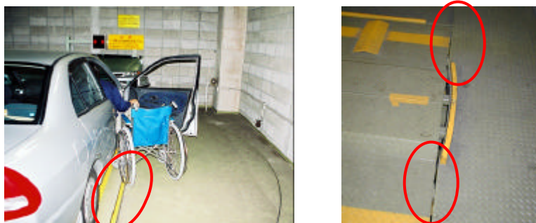
写真一 乗降部および通路の段差の解消、隙間の縮小
