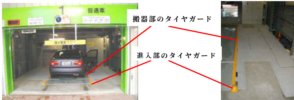
写真-タイヤガードの設置
