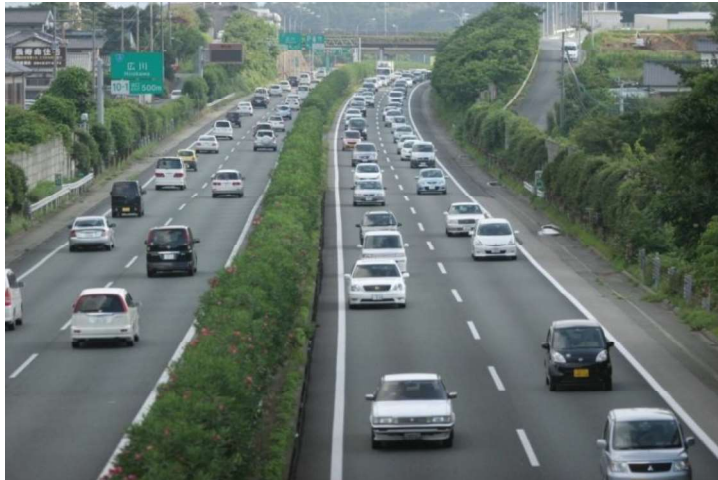
九州自動車道(福岡県)
