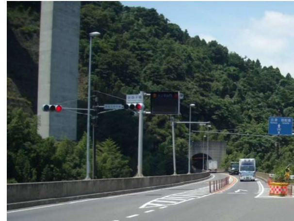
国道246号山北バイパス(神奈川県山北町)
