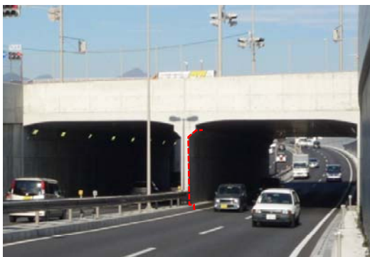
一般国道17号 高松立体(群馬県高崎市)
