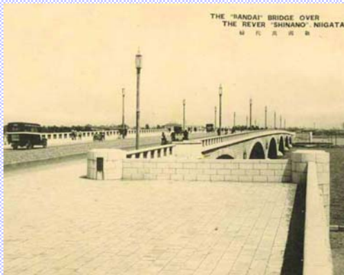
建設当時の萬代橋 1929(昭和4)年8月竣工
