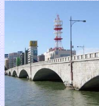
照明灯・橋側灯の復元
